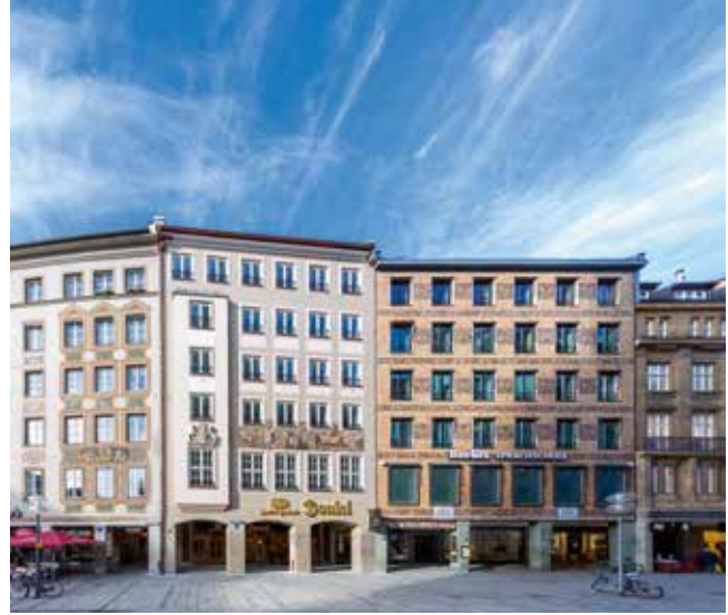
Die Fassade aus den 1950er-Jahren blieb bestehen.
