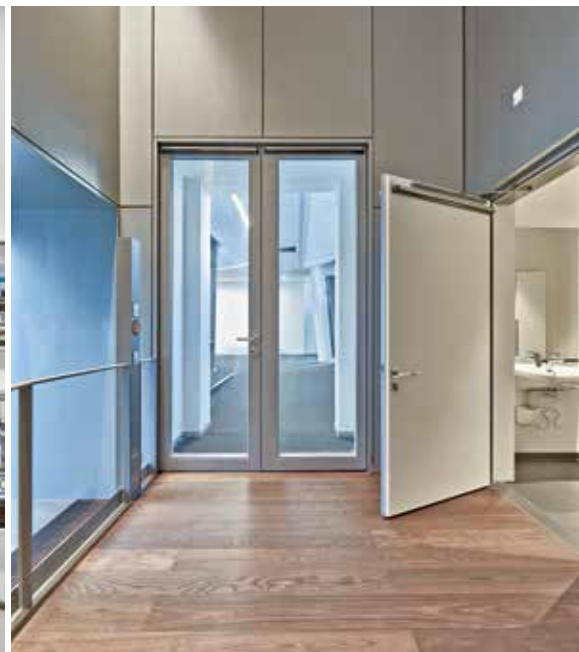
Holz-Brandschutztür mit Glasausschnitt sowie WC-Tür.
