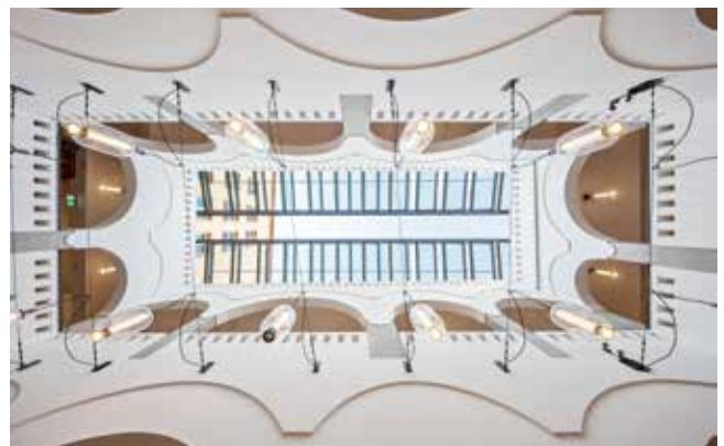
Das Glasdach kann bei Bedarf geöffnet werden.
