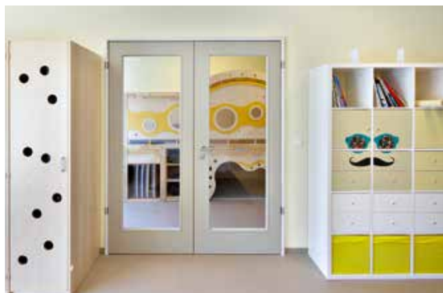
Schallschutztür 2-flügelig mit Lichtausschnitt und Stahlrundformzarge.
