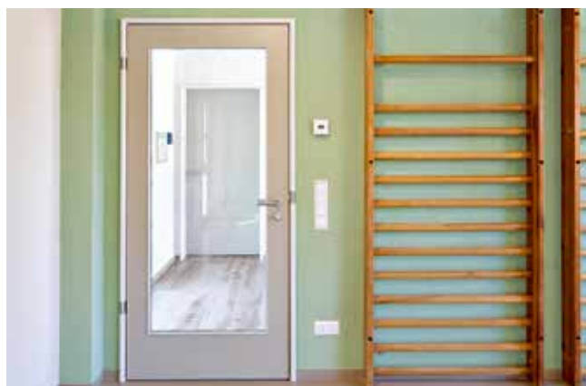
Brand- und Schallschutztür mit Stahlrundformzarge „Kita-Ausführung“.
