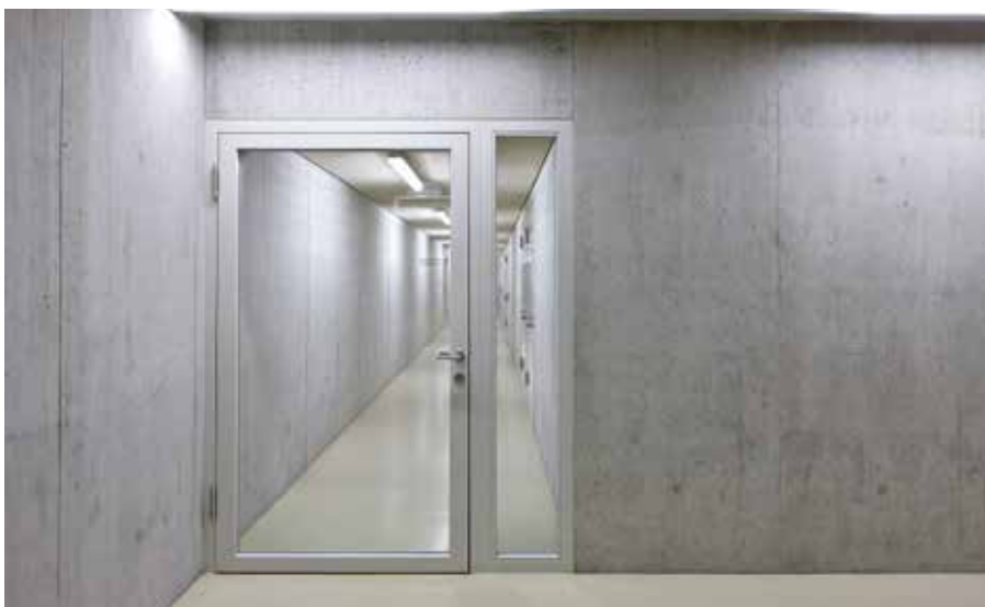
Auf Glasleisten kann bei der neuen Massivholz-Rahmentür von Schörghuber verzichtet werden.
