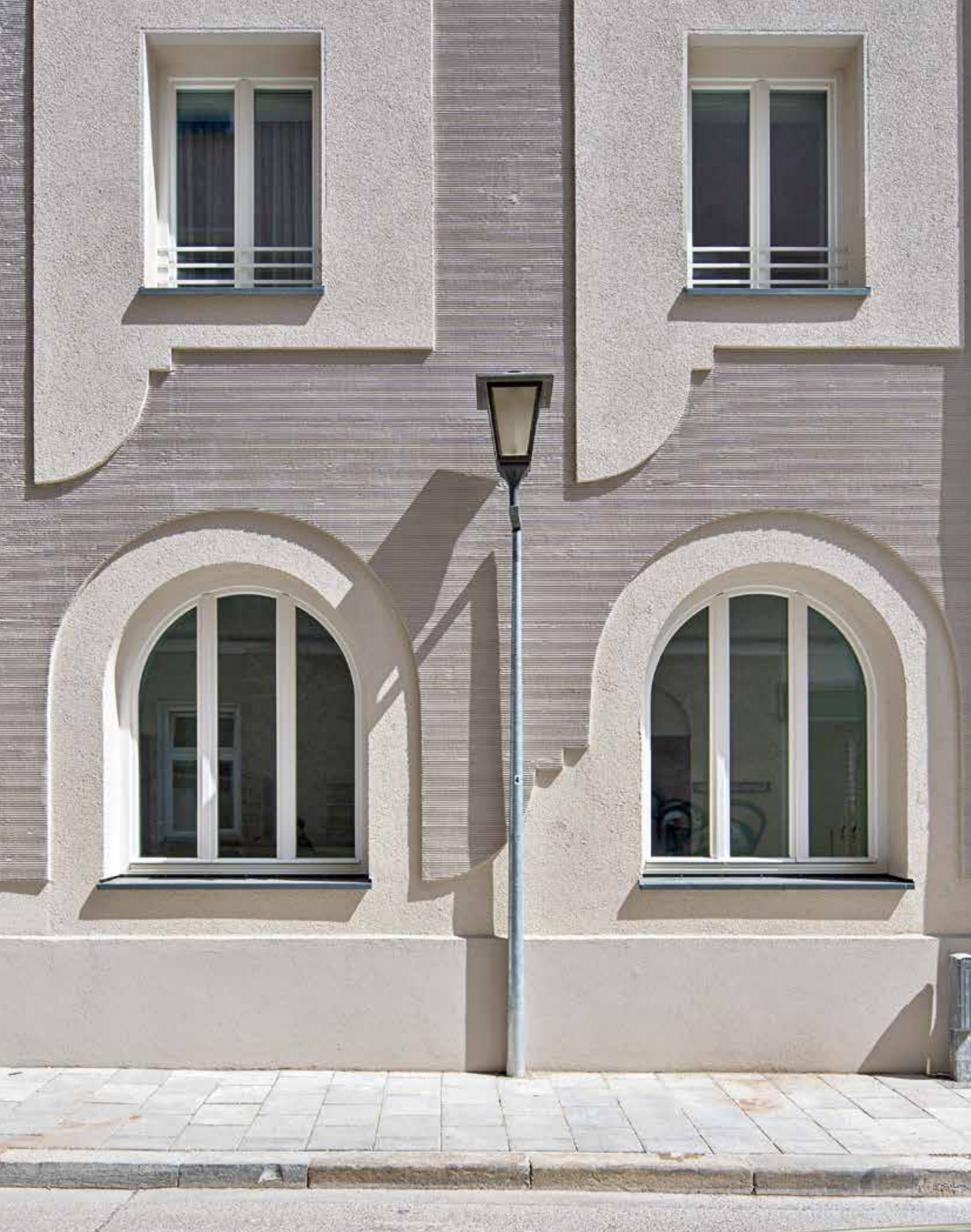
Fassadendetail von Hild und K: moderne Interpretation von Stuckarbeit.
