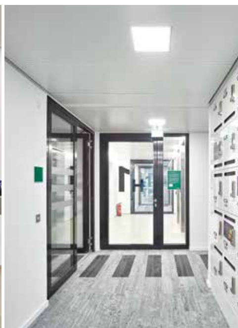
Rohrrahmentür mit feststehendem Lichtflügel.
