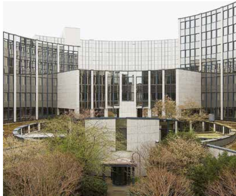
Der Zustand des Gebäudes vor ...
