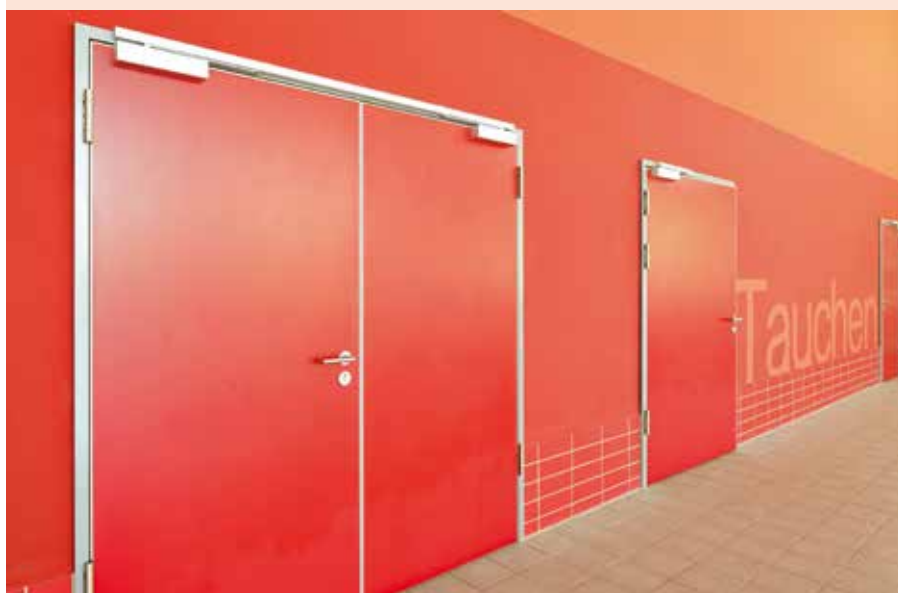
Optisch gleicht die Zarge einer Holzzarge und kann auch mit T30 Brandschutzfunktion ausgeführt werden.
