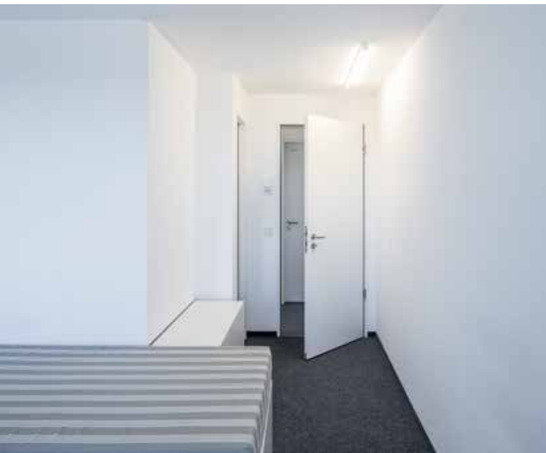
Die Zimmertüren mit Schallschutzanforderung haben eine Stahlzarge.
