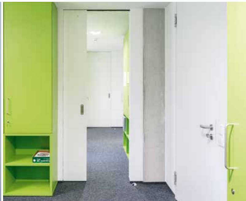
Platzsparende Schiebetüren verbinden die Räume der Verwaltung.
