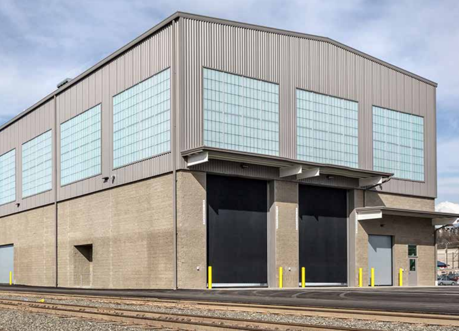
MODELO HD-DD 3065 en unas instalaciones de mantenimiento de transporte ferroviario
