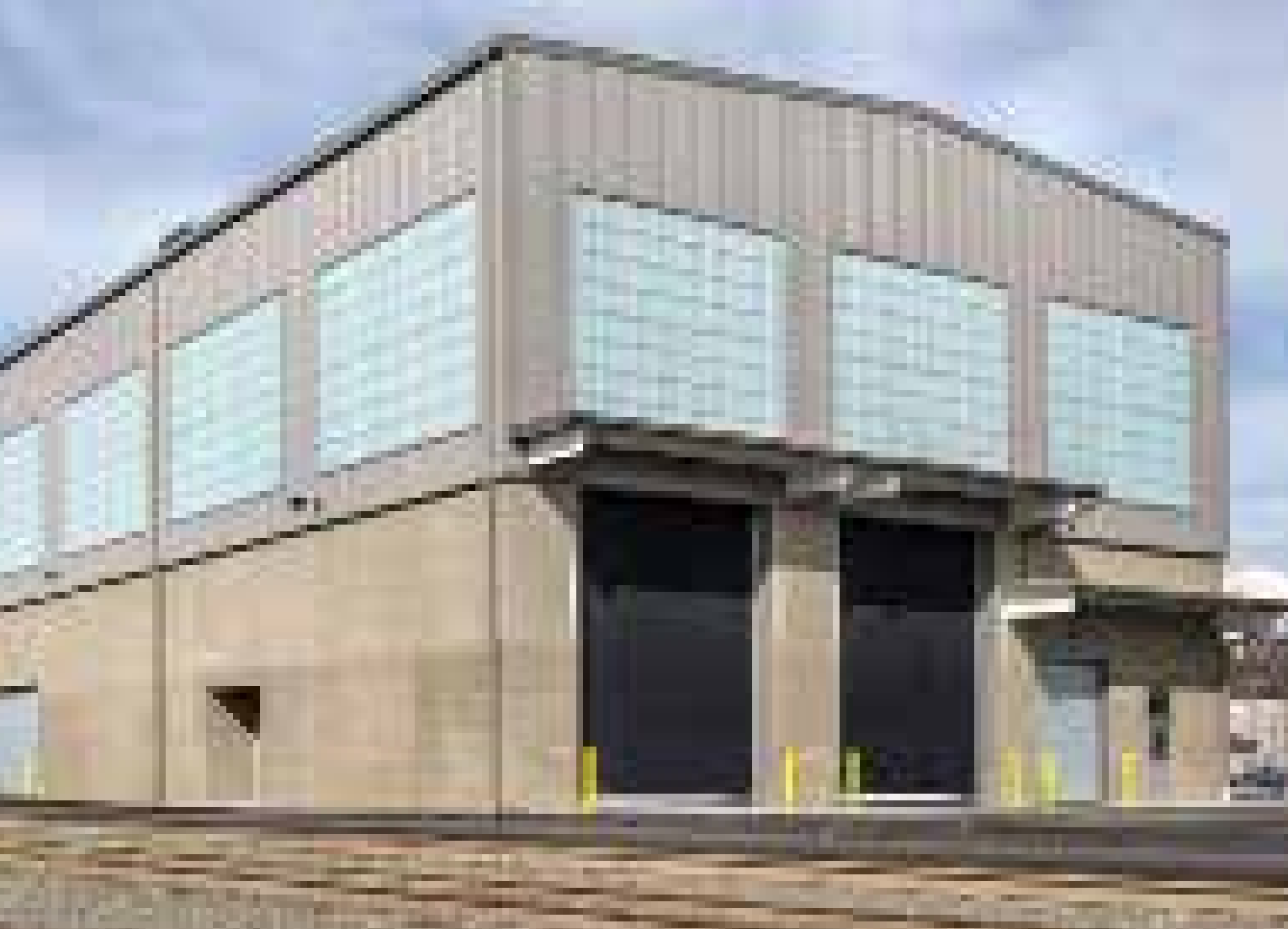
MODÈLE HD-DD 3065 dans un centre d'entretien du transport ferroviaire
